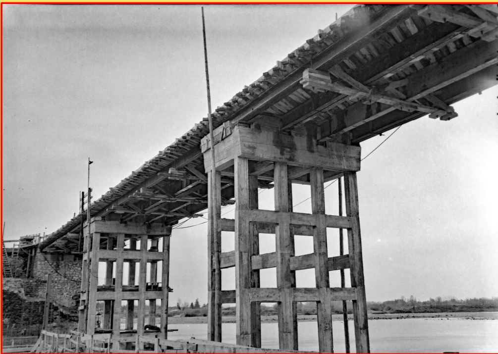
Fin 1944 on construit, entre la pile 16 et la rive sud et avec des matériaux de récupération, une passerelle en bois de 145 m de long sur 3,40 m de large
